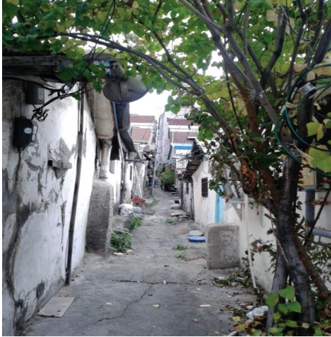
〈주안7동 해체 후 공원이 될 공간의 중심 골목길 (사진 출처/ 대안공간 둠)〉
