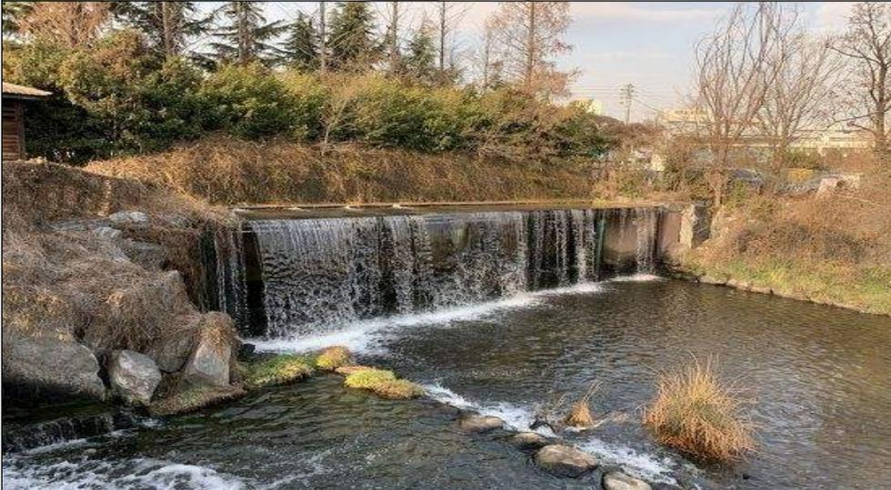
인천은 하천살리기사업을 일찍부터 시작했고 대표적인 곳이 승기천임. 승기천의 상류 대부분은 복개되어 하수도로 이용되고 있음. 인천터미널 부근에서부터 하류로는 열려있는데 과거 생활하수가 그대로 하천으로 흘러들어 수질을 악화시켰음. 하천정비사업을 진행하여 하천이 열려있는 구간에서부터는 하수관을 묻어 생활하수를 차집해서 하수종말처리장까지 이동하여 처리하고 있음. 비가 많이 내려 하수관 용량을 초과하는 경우를 제외하고 평소에는 생활하수가 흘러들지 않고 있음. 평소 부족한 하천유지용수는 하수종말처리수를 끌어다 이용하고 있음.
